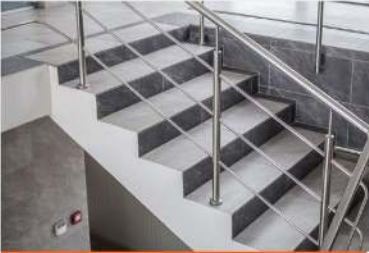
Korkuluk Küpeste Montajı Guardrail Installation
