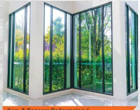
Kapı & Pencere Doğramaları / Doors & Windows Installations
