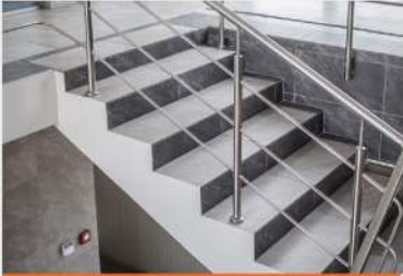
Korkuluk Küpeşte Montajı Guardrail Installation
